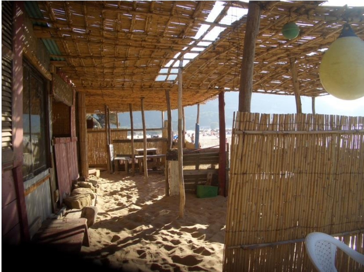
Terraza de chiringuito con techado para dar sombra, construida con materiales naturales.
