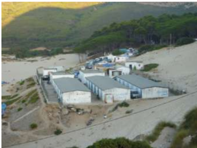
Infraestructuras de apoyo a la pesca en playa Dalia. Fuente: Planificación y Desarrollo Sostenible S.L.
