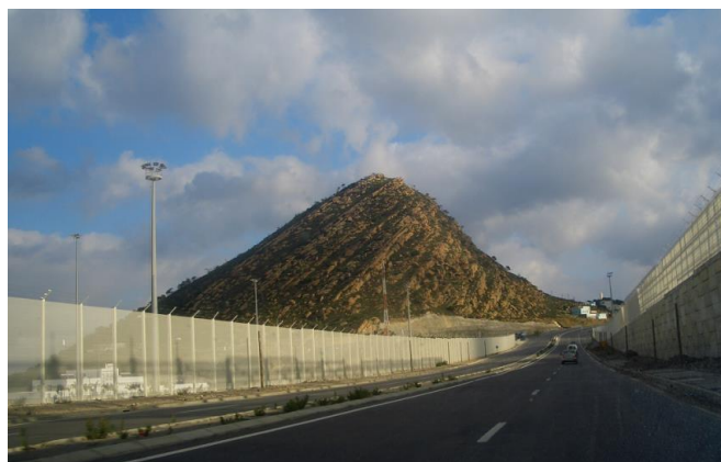
Figura 108: Carretera entrada al SIBE desde Puerto Tánger Med. Fuente: Elaboración Propia.
