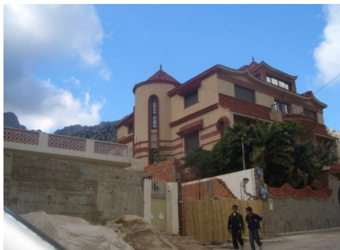
Figura 27: Edificación de nueva construcción en Belyounech. Fuente: Elaboración Propia.
